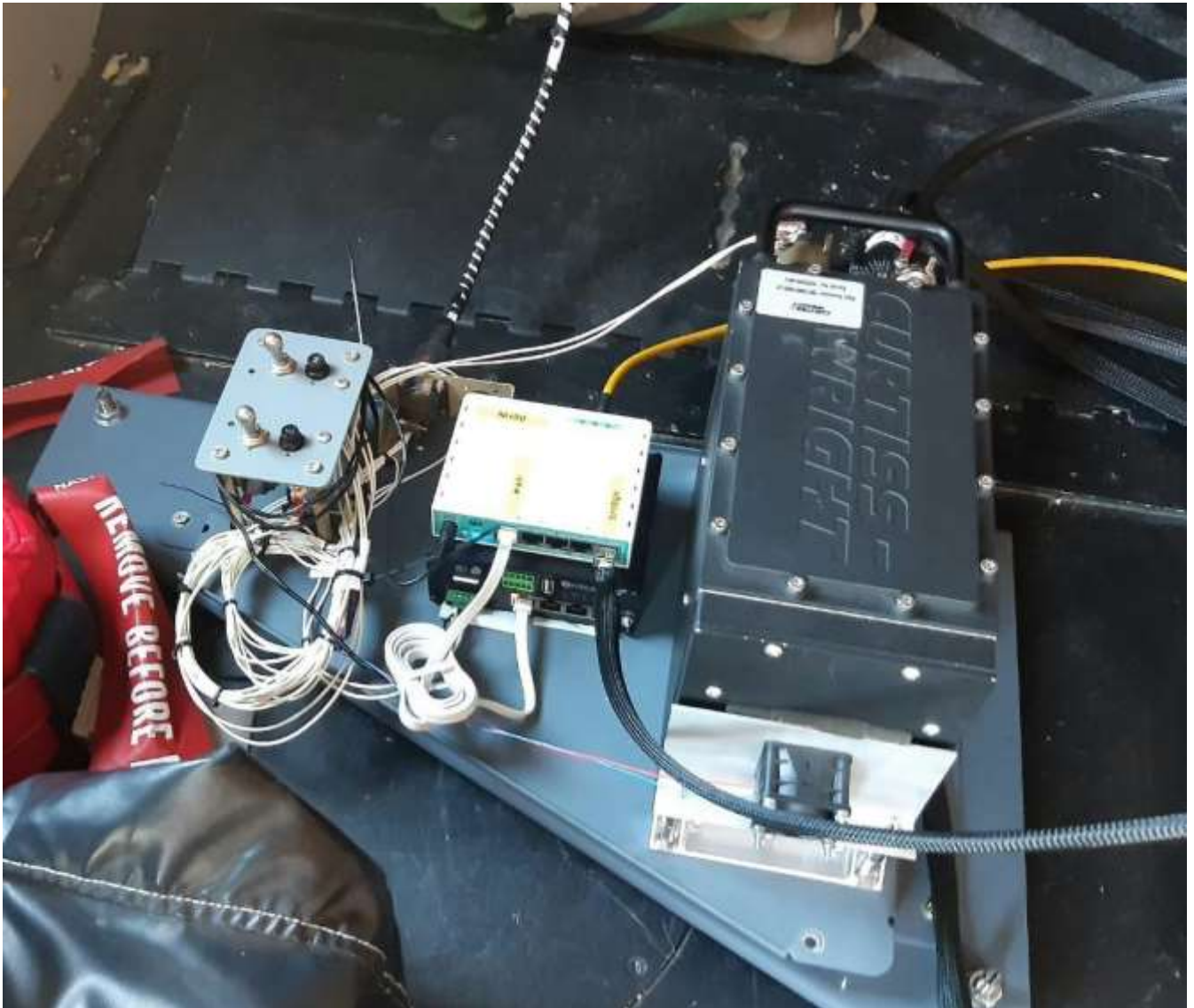
Figura 14. Imagen de la Instalación Final en el NH90
